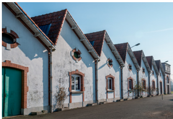
Melay (Chemillé en Anjou) Usine de chaussure (Groupe ERAM) photographie ©Dominique Drouet
